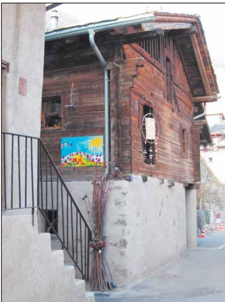
Cette grange de Branson est devenue l'atelier de Nicole Magnin, après une transformation qui a préservé sa façade.
