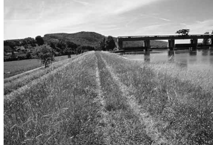
Technische Bauwerke wie dieser Damm bei Leibstadt sind wertvolle Ersatzstandorte.
